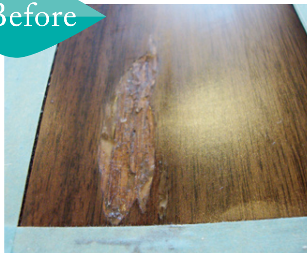
施工場所 リビング窓際
