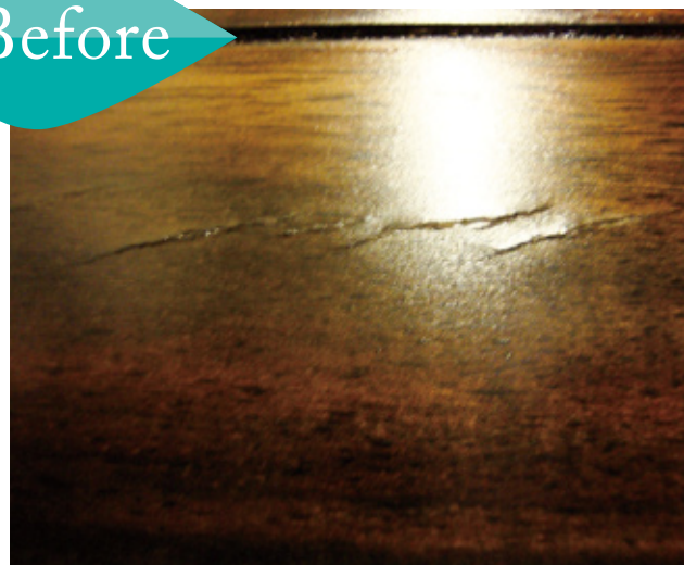
施工場所 キッチン入口
